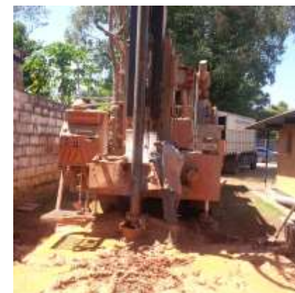
Slaan van de boorput voor water
