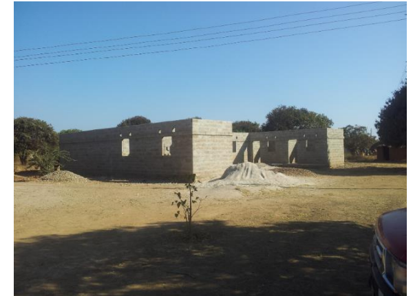
Community hall in aanbouw
